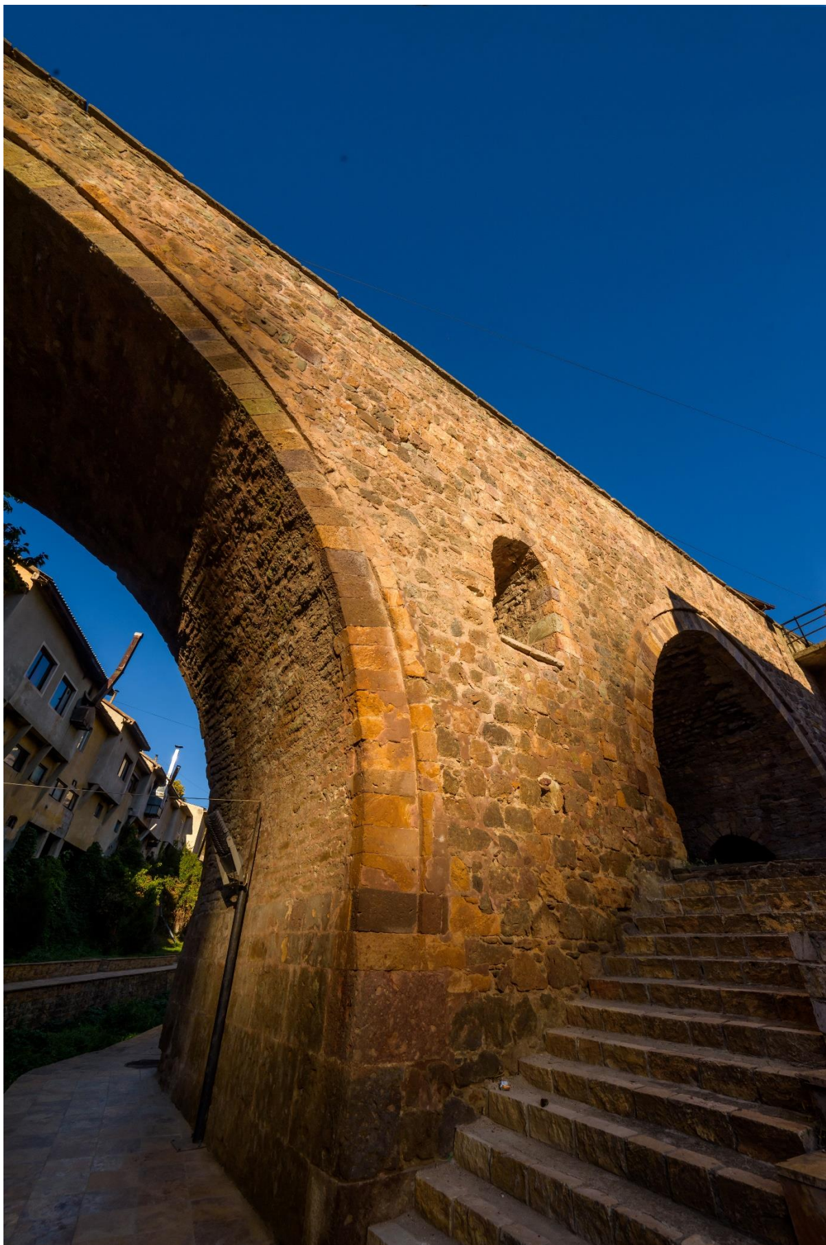
Мостовите во Кратово се едни од туристичките обележја на градот - Грофчански мост
